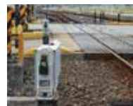
踏切障害物検知装置 東員12号踏切
